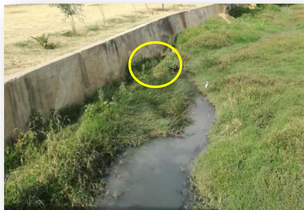
Punto de descarga de aguas residuales hacia el río Tamborada, a la altura de la U. E. 6 de Agosto, (ribera norte).
