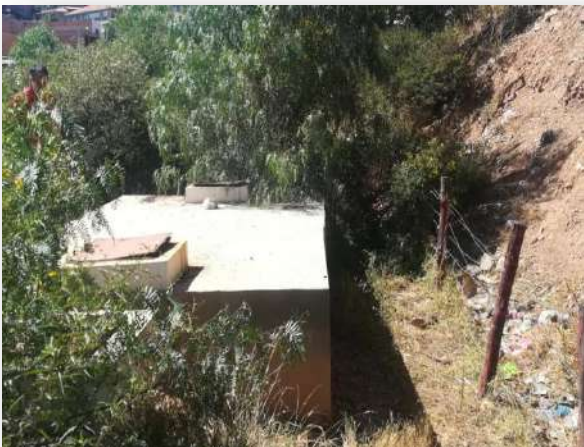
Tanque séptico colmatado de donde proviene la filtración de agua residual
