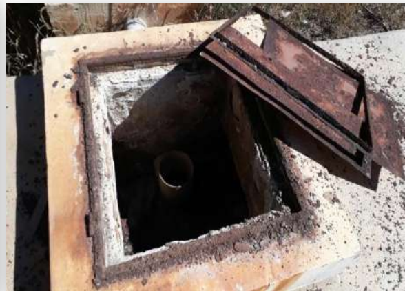
Tanque séptico colmatado de donde proviene la filtración de agua residual
