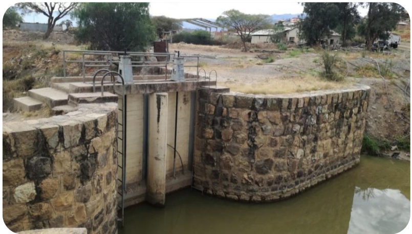
Obra de toma Santa Vera Cruz (inicio de la distribución de la red de riego)
