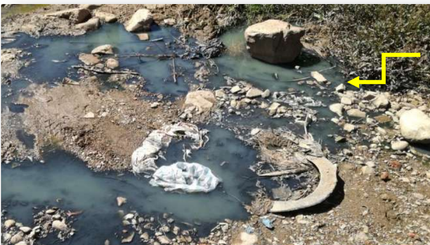
Tanque séptico colmatado de donde proviene la filtración de agua residual
