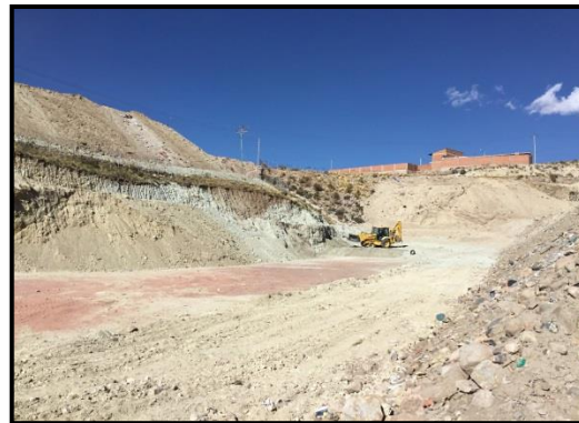
Imagen 25 Compactación de Celda
