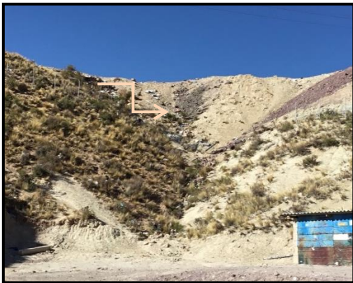
Imagen 1. Cerco perimetral derrumbado
