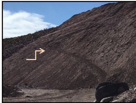
Imagen 2. Área sin cerco perimetral
