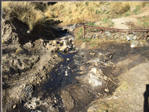
Derrame de la piscina de lixiviados a al quebrada
