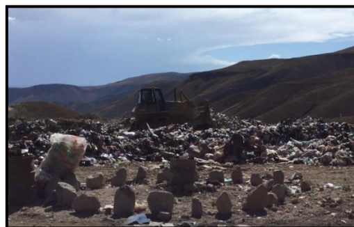
Imagen 21 Compactación con Tractor Oruga
