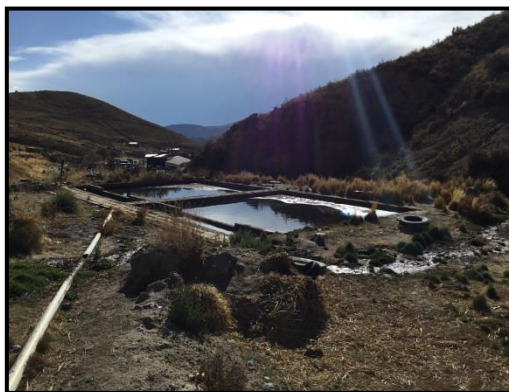
Imagen 8 Tuberías para direccionar la generación de lixiviados
