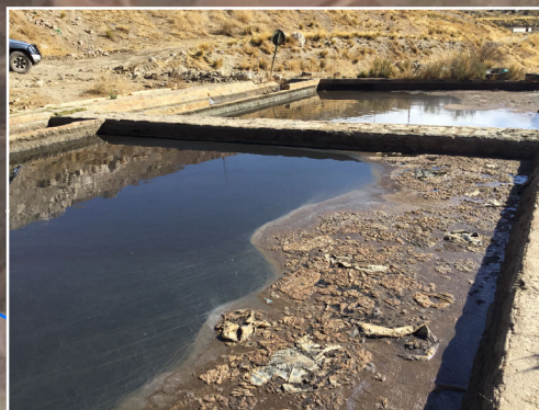
Piscinas de Lixiviados
