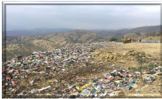
Fotografía 23. Formación de banquinas con maquinaria pesada
