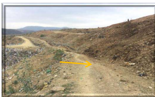
Fotografía 22. Primera banquina sin impermeabilización
