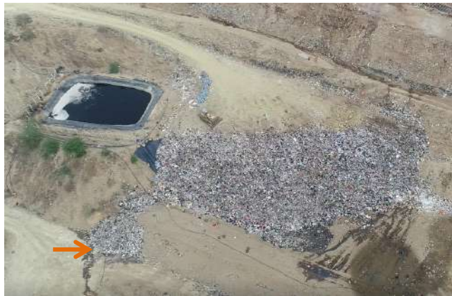
Fotografía 27. Talud sin drenes de captación
