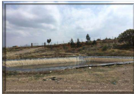
Fotografía 15. Piscina impermeabilizada
