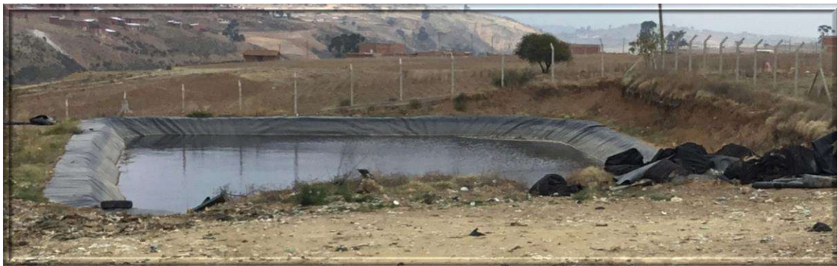
Fotografía 13. Área sin zanjas de coronación
