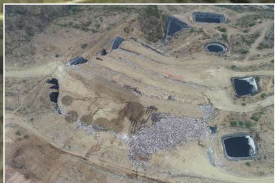
Piscinas de lixiviados
