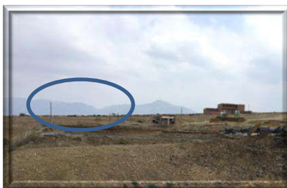
Fotografía 16. Cerco perimetral en buen estado
