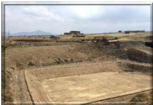
Fotografía 9. Piscina en mantenimiento
