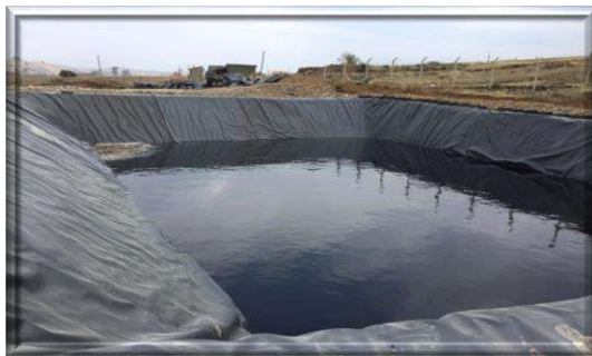
Fotografía 8. Piscina de lixiviados de emergencia
