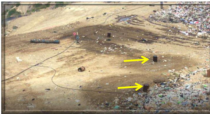
Fotografía 24. Rociadores de lixiviados
