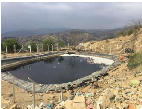
Fotografía 28. Personal piscina de lixiviados
