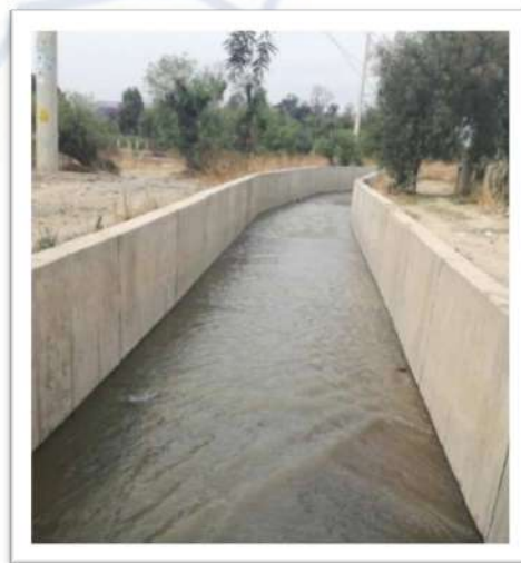
Tramo canalizado del río Chijllawiri luego de atravesar la avenida Blanco Galindo
