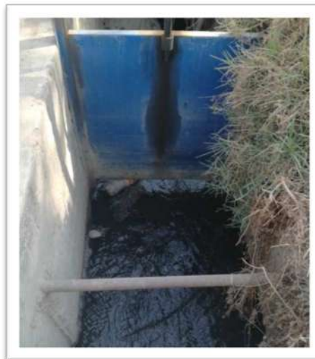
Primer punto de descarga de agua residual no tratada hacia un canal de riego en la calle Tiburcio Meneses
