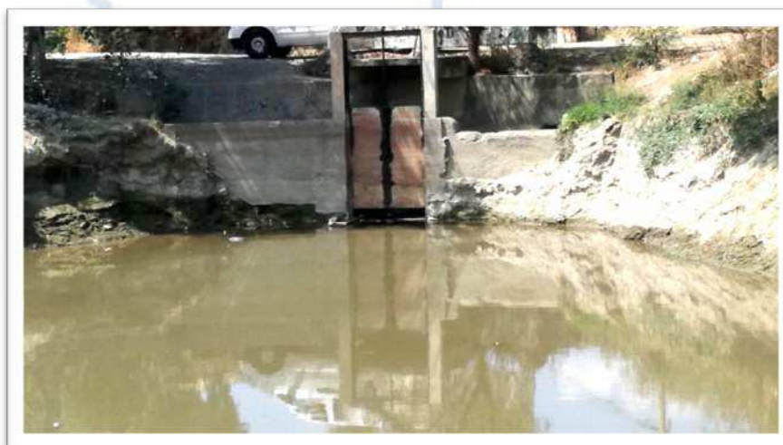
Compuerta de salida de agua de la laguna
