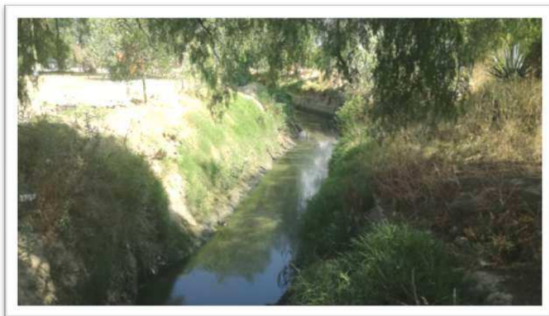
Canal de ingreso de agua a la laguna de Coña Coña
