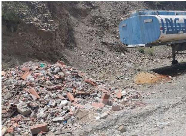
*Inadecuada disposición de residuos especiales de construcción en el camino El Alto- Mallasilla.*
