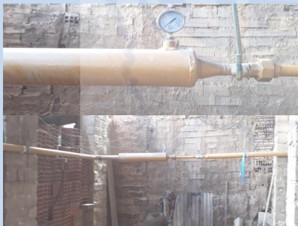
Instalación de Gas Natural.
