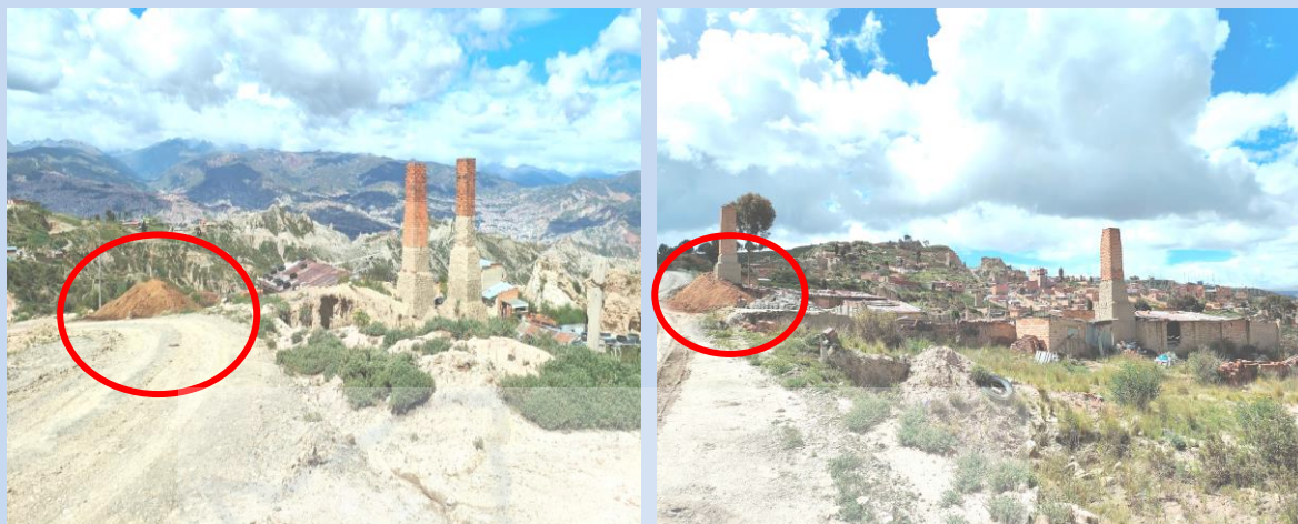
Ladrilleras que usan aserrín como combustible para la cocción de ladrillos.
