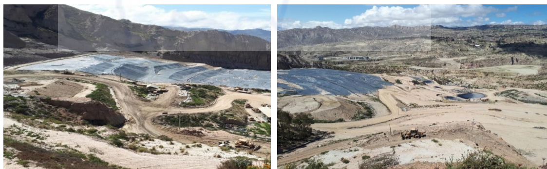
Relleno sanitario Nuevo Jardín de Alpacoma (etapa de cierre)
