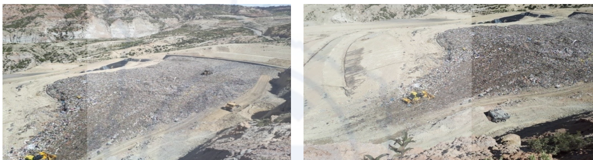
Relleno sanitario de Sak'a Churu
