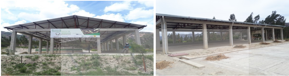
Planta de Transformación de residuos orgánicos
