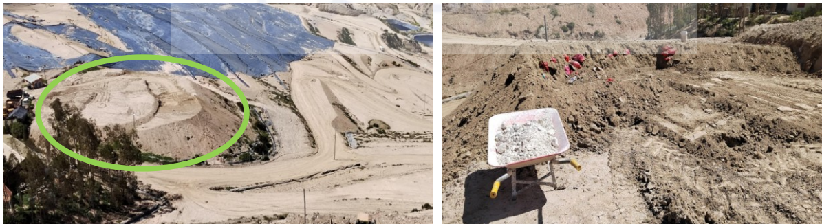
Celda en el relleno Nuevo Jardín de Alpacoma y compactación de los residuos patógenos
