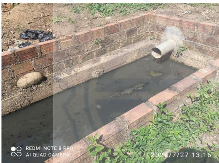
*Punto de descarga de agua residual de la red de alcantarillado sanitario del poblado de Isinuta y curso de la descarga hacia un arroyo.*
