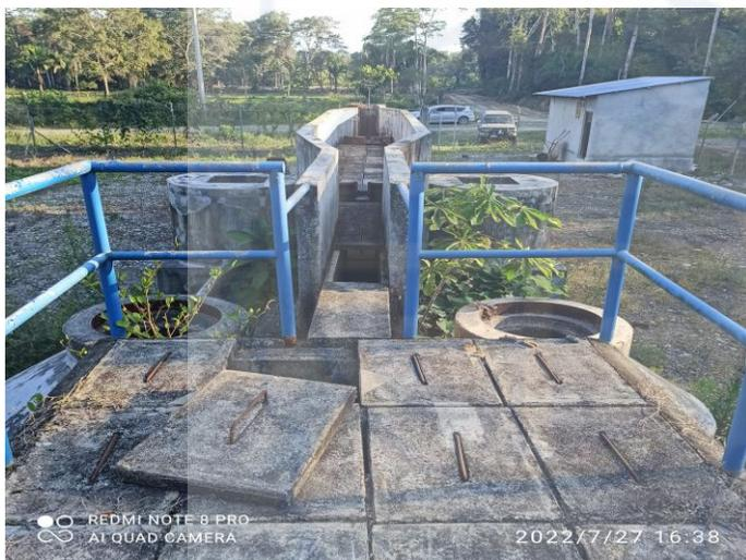
*Tanques de sedimentación y biofiltros conforman el sistema de tratamiento en el poblado de San Francisco km 21*
