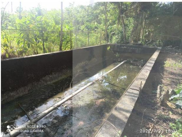
*Filtro sin funcionamiento y tanque séptico colapsado en el poblado de Eterazama*
