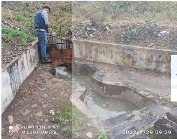
*Ingreso del agua residual a la cámara séptica y biofiltros en el sistema instalado en el poblado de Villa Tunari*
