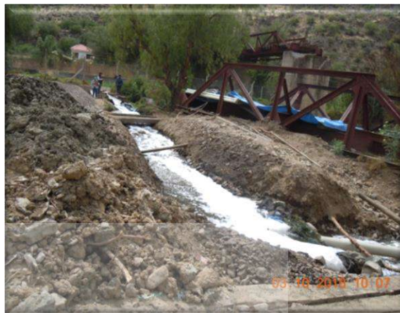
P24. Descarga de la PTAR El Campanario
