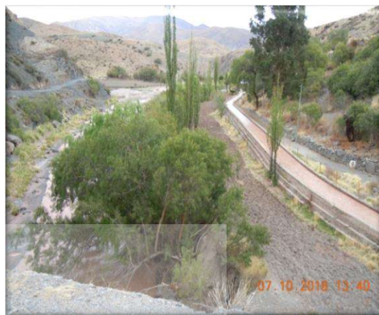
Canal de desvío de agua del río Pilcomayo
