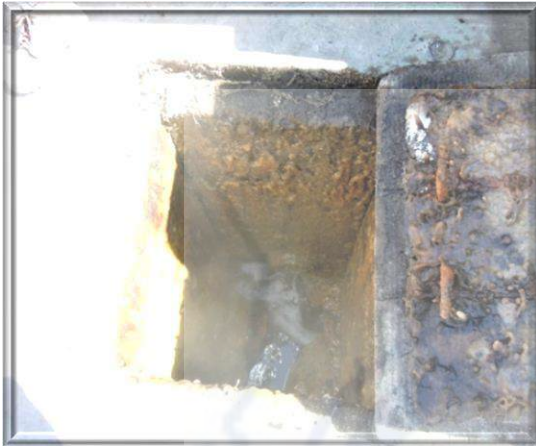
Cámara de descarga de efluentes
