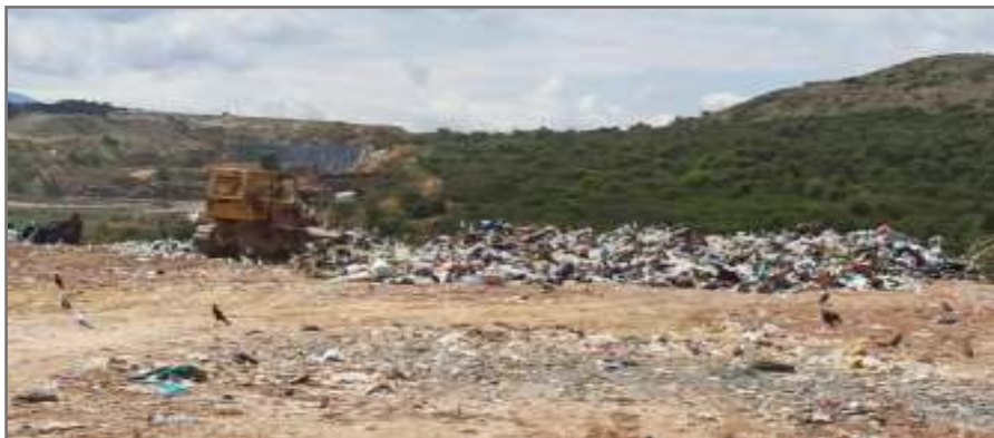
Remoción de los residuos depositados en la macrocelda con el tractor oruga
