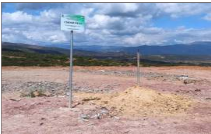
Chimenea con quemador
