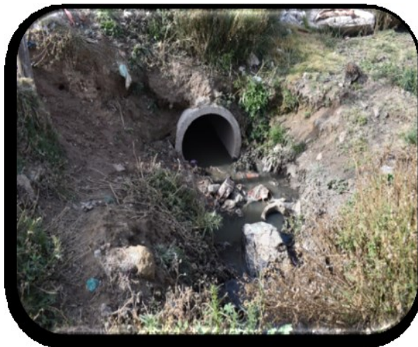
Descarga de aguas residuales domésticas de la zona del cuartel Bolívar en el municipio de Viacha
