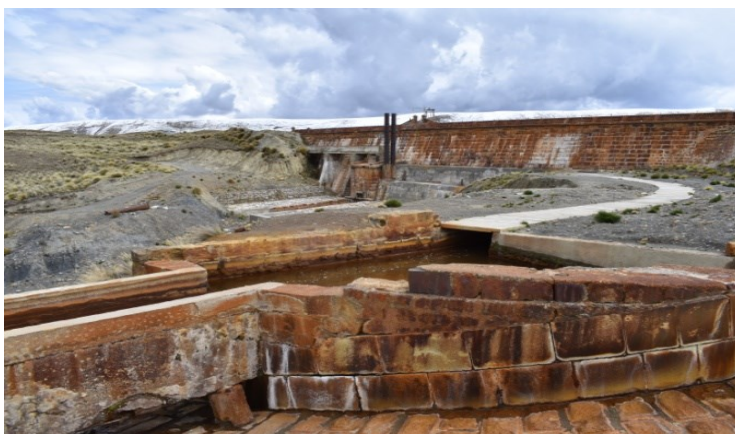
Canal de salida de la represa de Milluni para tratamiento de agua potable
