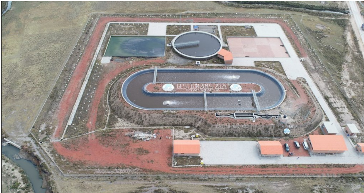
Vista panorámica de la PTAR de Viacha a mayo de 2023. A la izquierda de la PTAR se puede observar el río Pallina donde se descargan los efluentes tratados en la PTAR
