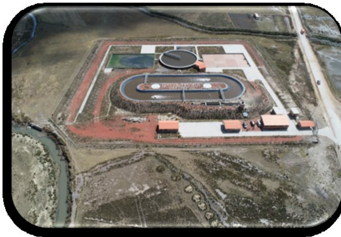
PTAR de Viacha, sus aguas tratadas son eliminadas al río Pallina
