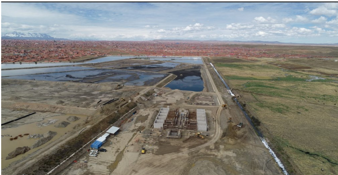
Situación de la ampliación de la PTAR de Puchuckollo a mayo de 2023
