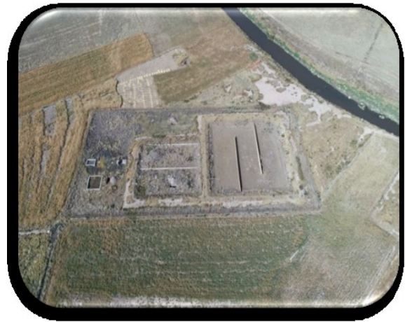
PTAR de Laja sin operación
