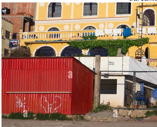
Ubicación del cárcamo de bombeo
