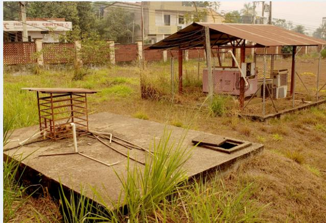
Motor de generador de luz, tanque y bomba de agua sin funcionamiento
