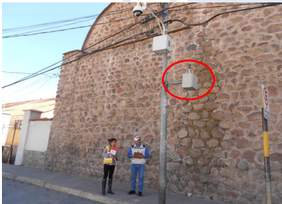
Figura 2. Vista general del sitio Plaza San Bernardo (PSB)
