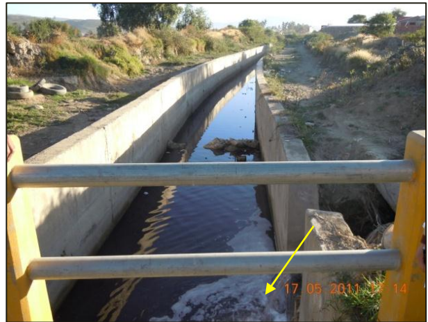
23.-Descargas de SENDTEX y de la UPB al canal Valverde.
