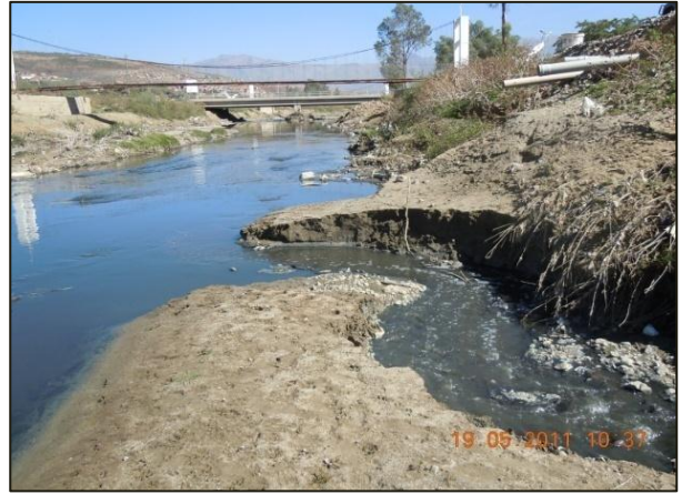
39.- Descarga de ARD al río Rocha, tanque V. de Urkupiña.
