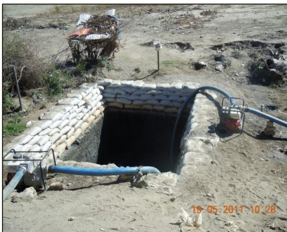
37.- Bombeo y descarga directa de aguas residuales domésticas al río Rocha en la zona de FRUCTUOSO MERCADO (Quillacollo).
