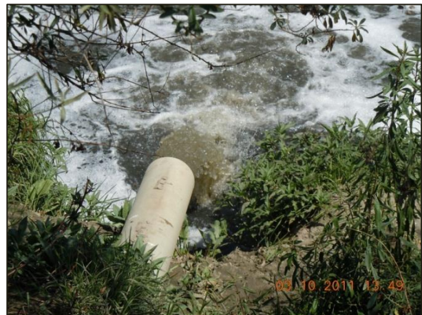
25.- Descarga del cárcamo de bombeo municipal de Colcapirhua.
