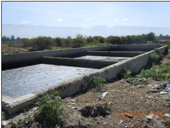
40.-Tanque sedimentación ARD zona Tomas Bata.
