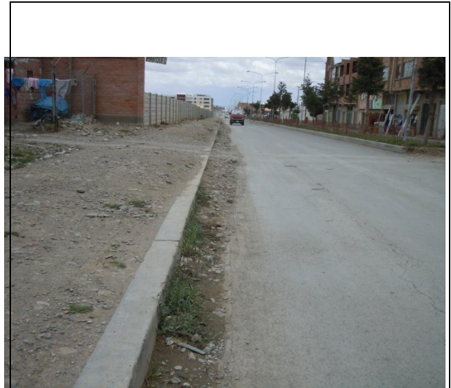
Foto N° 66: Av. Sucre – Acumulación de tierra en la cuneta y presencia de vegetación.
