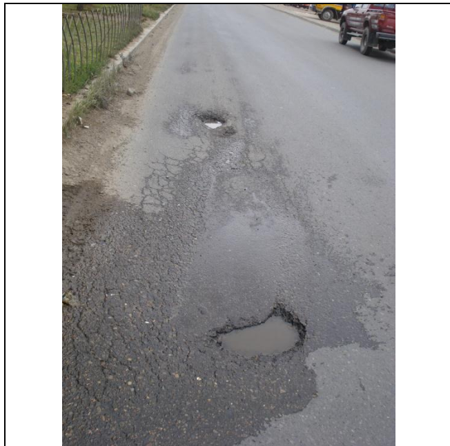
Foto N° 57: Av. 6 de Marzo – Baches en la calzada
