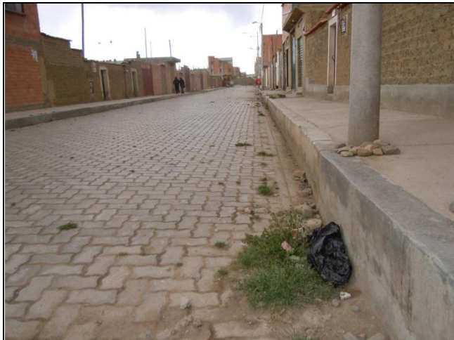
Foto N° 35: Calle General A. Escobar (Calle 25) – Vegetación en la cuneta.
