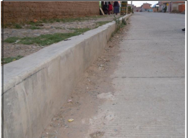
Foto N° 12: Av. Adela Zamudio – Acumulación de tierra que dio lugar a la presencia de vegetación al borde de la calzada
