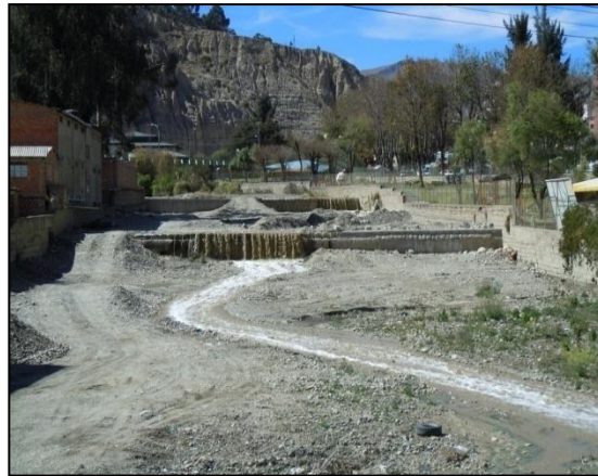
10.- Río Irpavi -Puente del Distrito Policial N°4 – La Florida.
