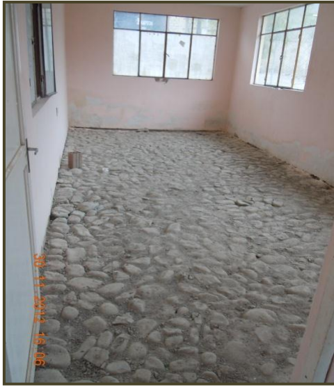
5.- Piso de cemento retirado para nuevo vaciado.
