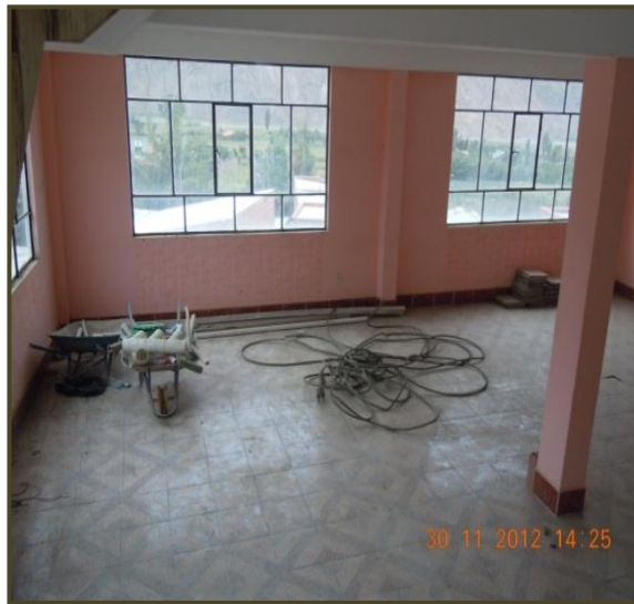
13.- Primer nivel del edificio donde opera el puesto.
