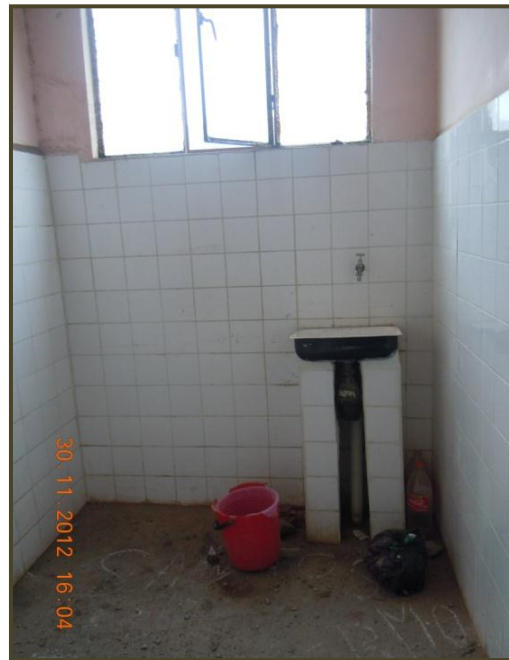
8.- Ambiente destinado a la cocina.
