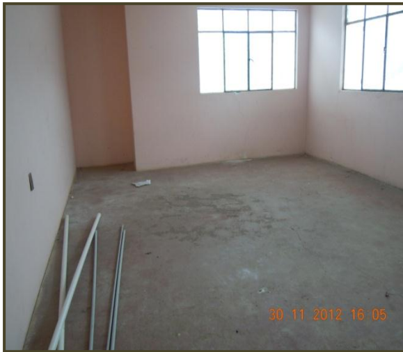
3.- Ambientes en refacción.
