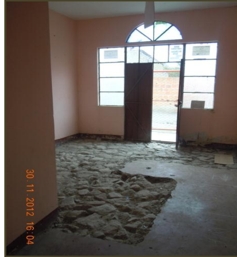
2.- Vista interior del ingreso al Puesto de Salud.
