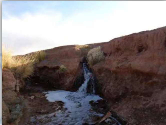
Canal de salida de las aguas tratadas en la PTAR
