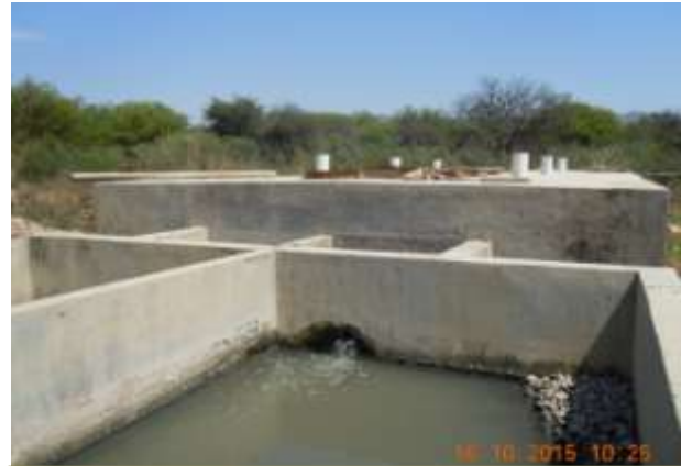
PTAR Valle de la Concepción – municipio de Uriondo
