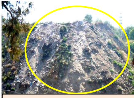
Zona afectada por residuos de escombros - 2011
