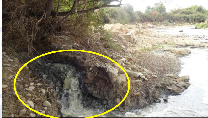
Punto de descarga de ARD crudas del municipio de Vinto hacia el río Rocha.
